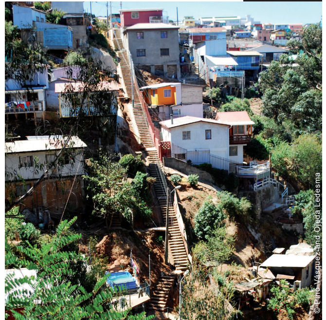
Las quebradas tienen un acceso sumamente difícil y una densidad de población muy alta, porque las familias construyen en terrenos ocupados de manera informal y tienden a ampliar sus viviendas con el tiempo.
