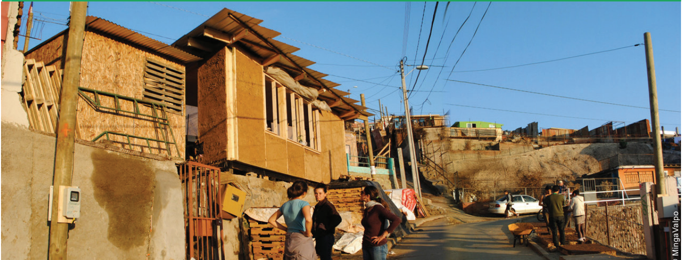
Con ayuda de arquitectos locales, se reconstruyeron muchas casas con los subsidios recibidos. Algunas fueron levantadas durante los talleres comunitarios de autoconstrucción, experimentando con materiales de bajo costo.
